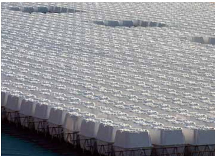
Príprava základovej dosky priemyselnej haly
