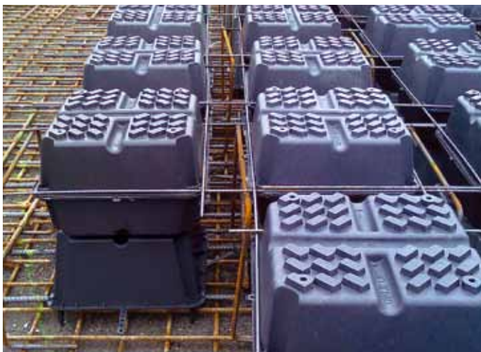
Príprava základovej dosky na nestabilnom podlaží
