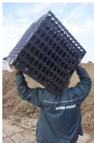
2 Nízká hmotnost vsakovacích bloků usnadňuje manipulaci
